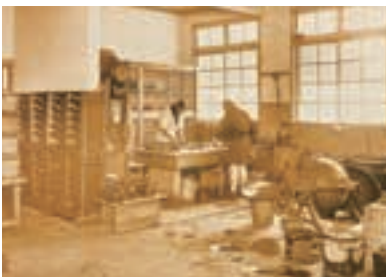
1928年5月に病棟の建設が始まり、第一期工事で病室や炊事場などが次々と建設されていった
