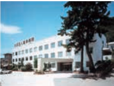
1977年に完成した本館。災害に強い施設とするため、病棟を優先して新築・改築を行い、最後に建てなおされた
