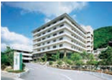
2006年に竣工した新本館。精神科病院の新しい在り方を考えたストレスケア病棟やコミュニケーションの輪を広げる職員食堂が新設された
